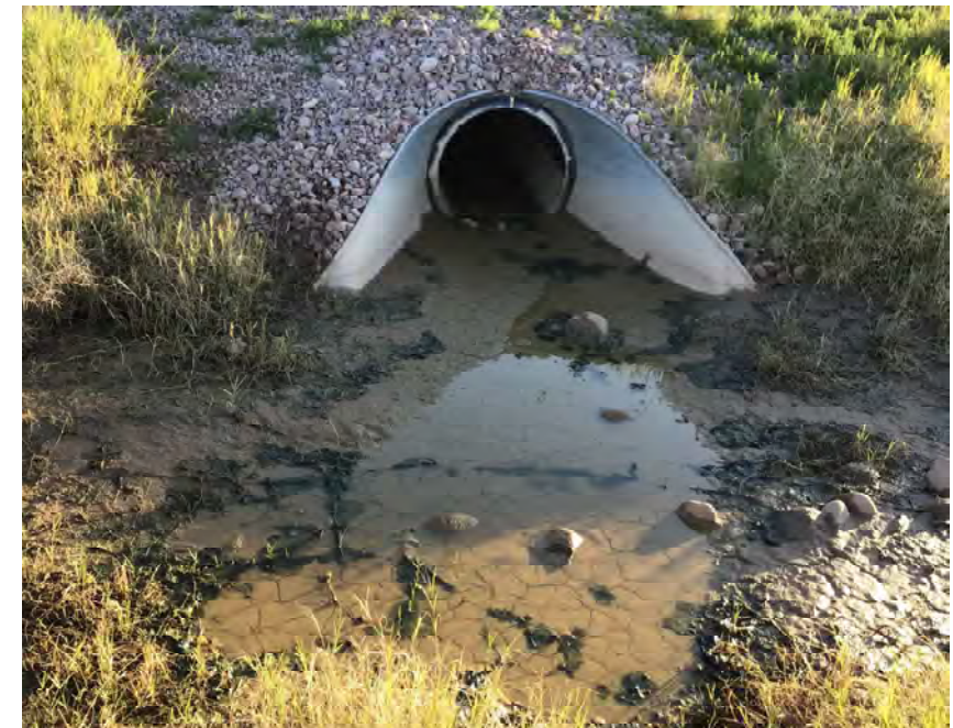
CULVERT #35 OUTLET 30" HDPE STA 959+00
