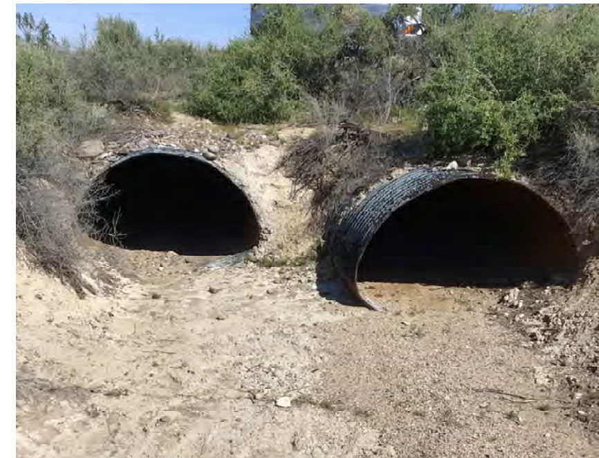
CULVERT #435 OUTLET (2) - 58" X 36" CMP ARCH STA 1461+83
