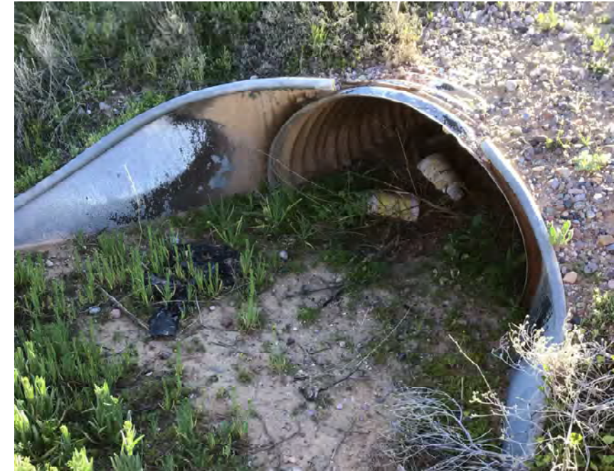
CULVERT #85 INLET 30" CMP STA 1033+00
