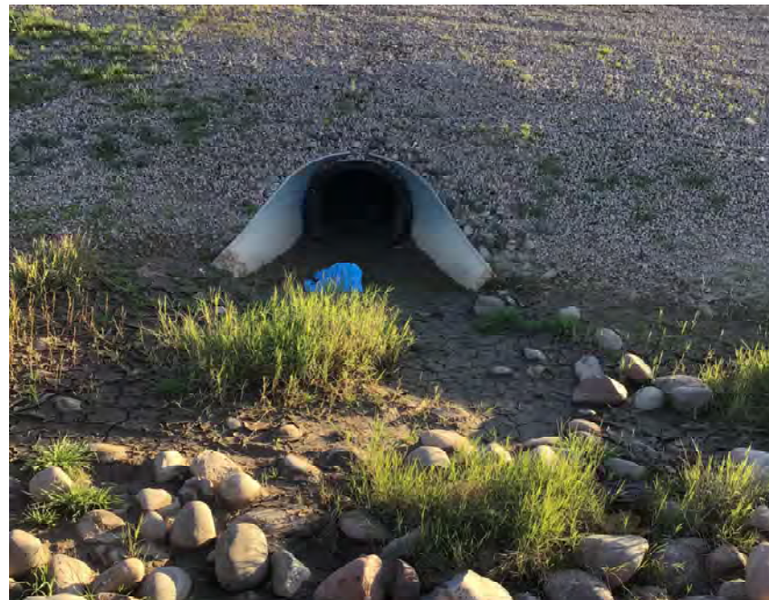
CULVERT #30 OUTLET 30" HDPE STA 954+25
