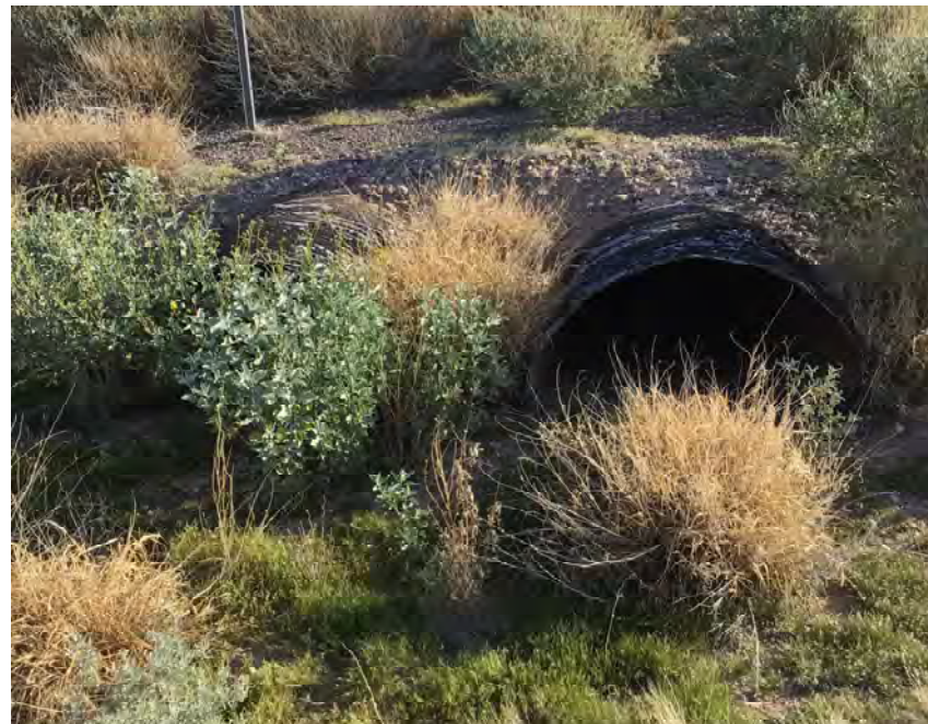
CULVERT #295 OUTLET (2) - 43" X 27" CMP ARCH STA 1279+00
