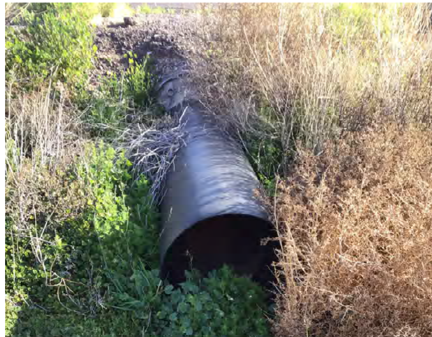
CULVERT #90 OUTLET 24" HDPE STA 1041+00
