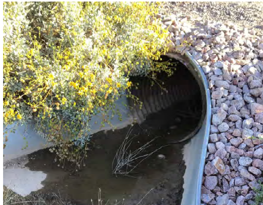
CULVERT #50 OUTLET 30" CMP STA 986+00
