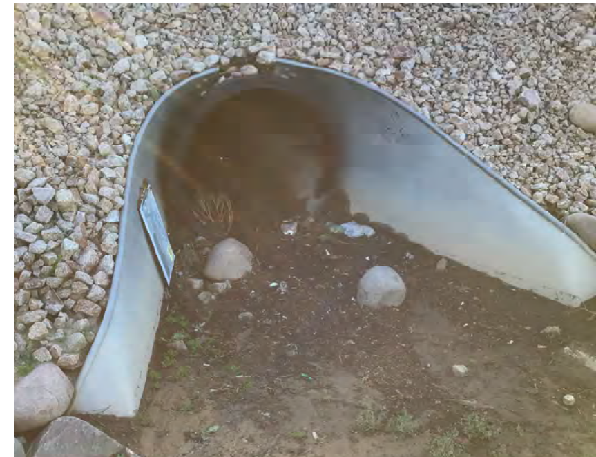
CULVERT #5 OUTLET 30" HDPE STA 926+57
