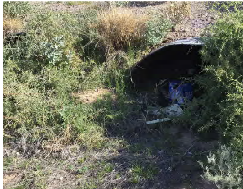
CULVERT #370 OUTLET (2) - 58" X 36" CMP ARCH STA 1371+00
