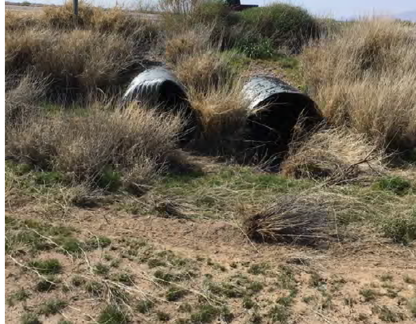
CULVERT #400 INLET (2) - 36" CMP STA 1411+00
