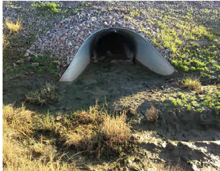
CULVERT #40 OUTLET 30" HDPE STA 964+00
