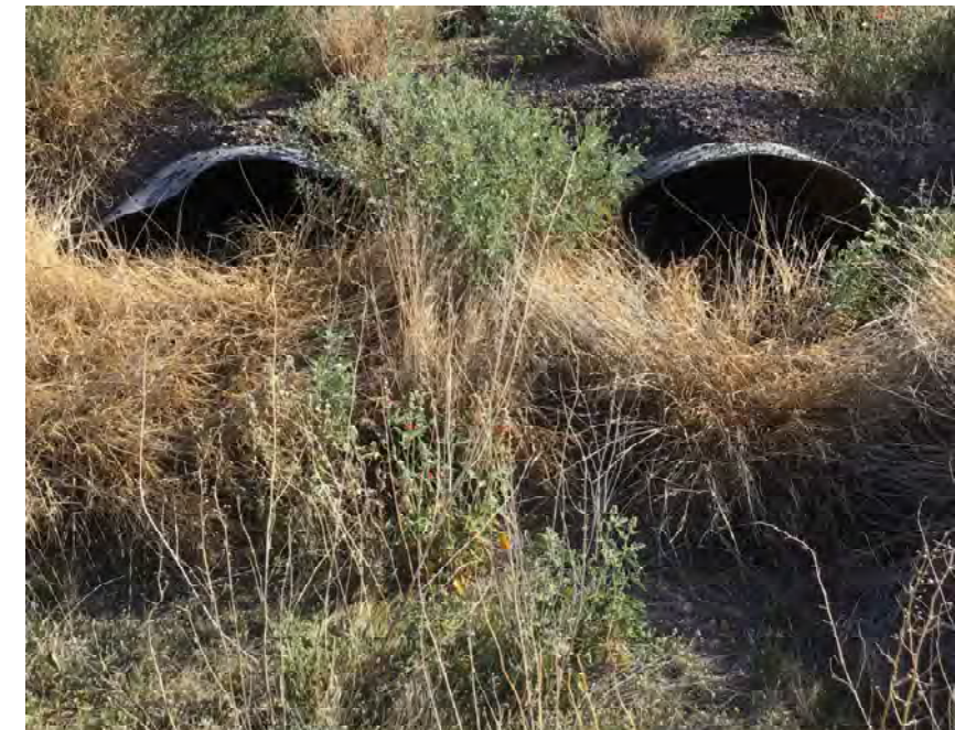
CULVERT #325 OUTLET (2) - 43" X 27" CMP ARCH STA 1311+00
