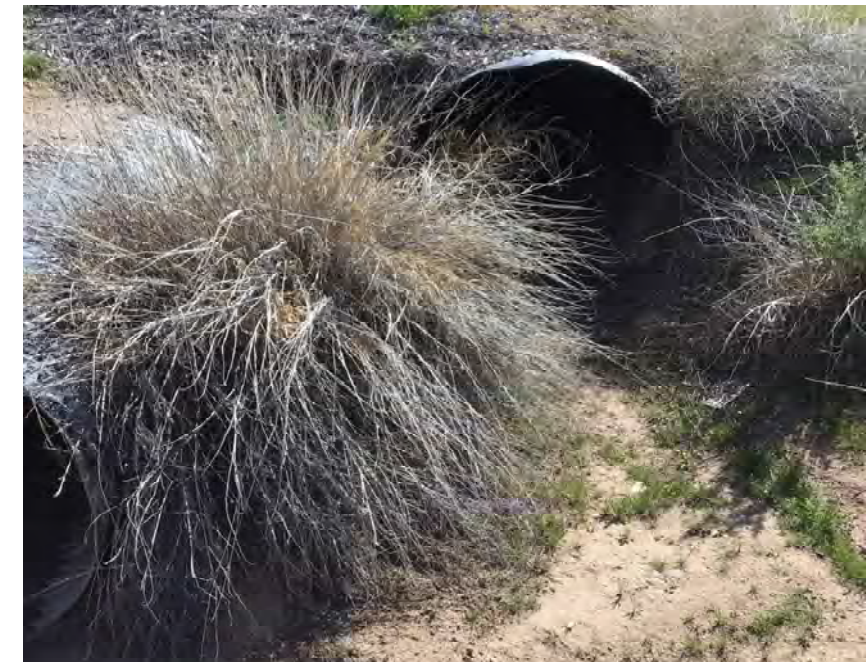
CULVERT #395 OUTLET (2) - 48" CMP STA 1404+47
