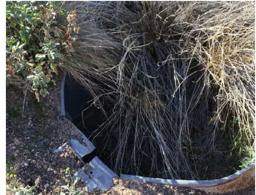
CULVERT #345 OUTLET (3) - 43" X 27" CMP ARCH STA 1335+00
