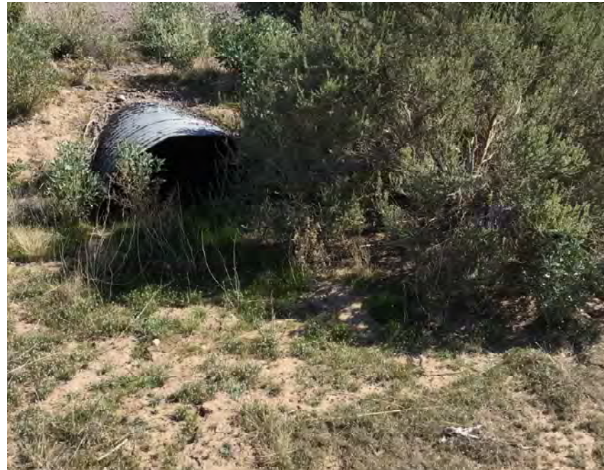
CULVERT #410 OUTLET (2) - 43" X 27" CMP ARCH STA 1423+00
