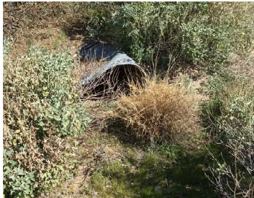
CULVERT #225 OUTLET 30" CMP STA 1211+00
