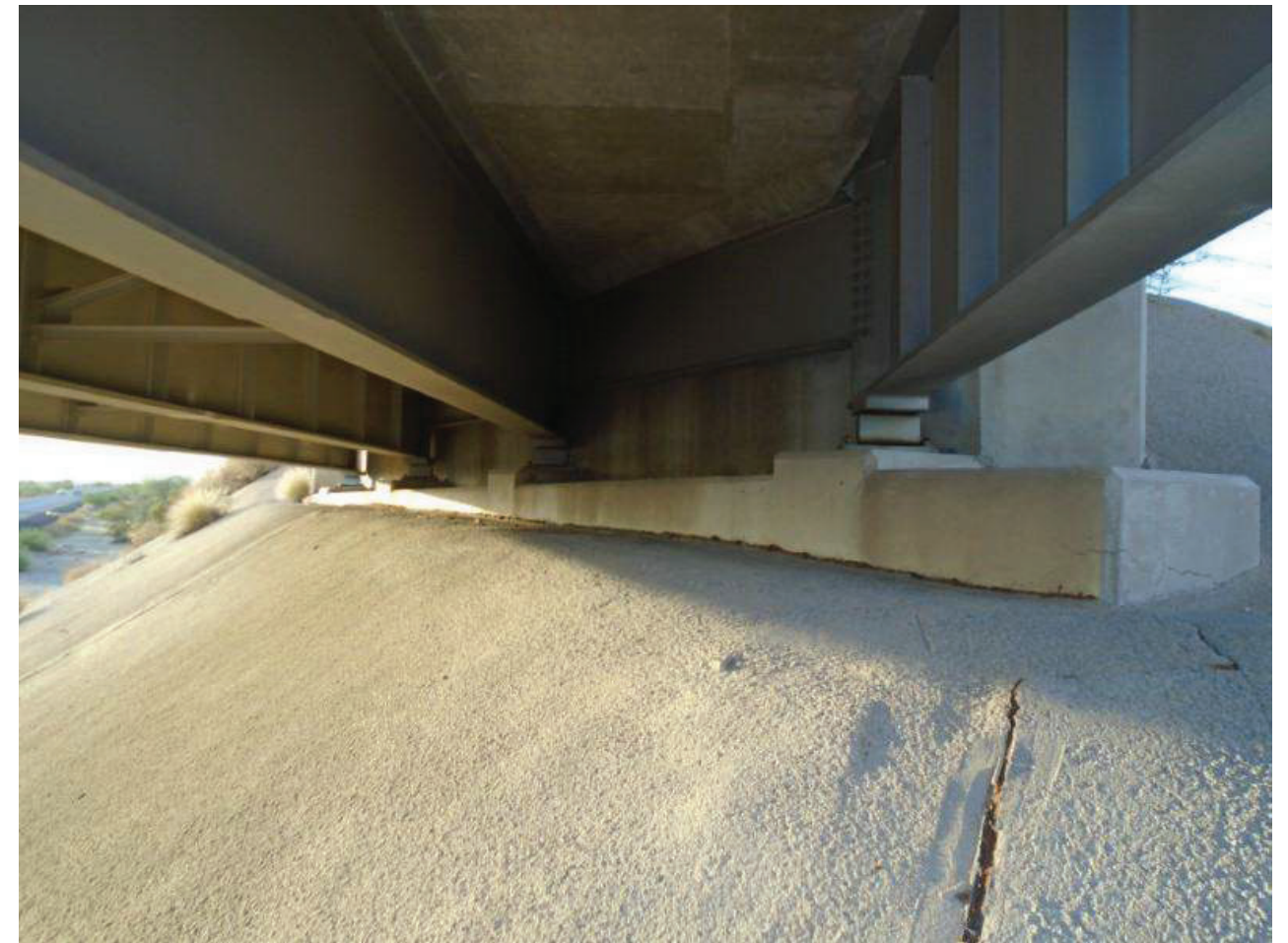
File Name : 01150-2020-05-31-Photo-10.JPG Description : N Abutment, LNW
