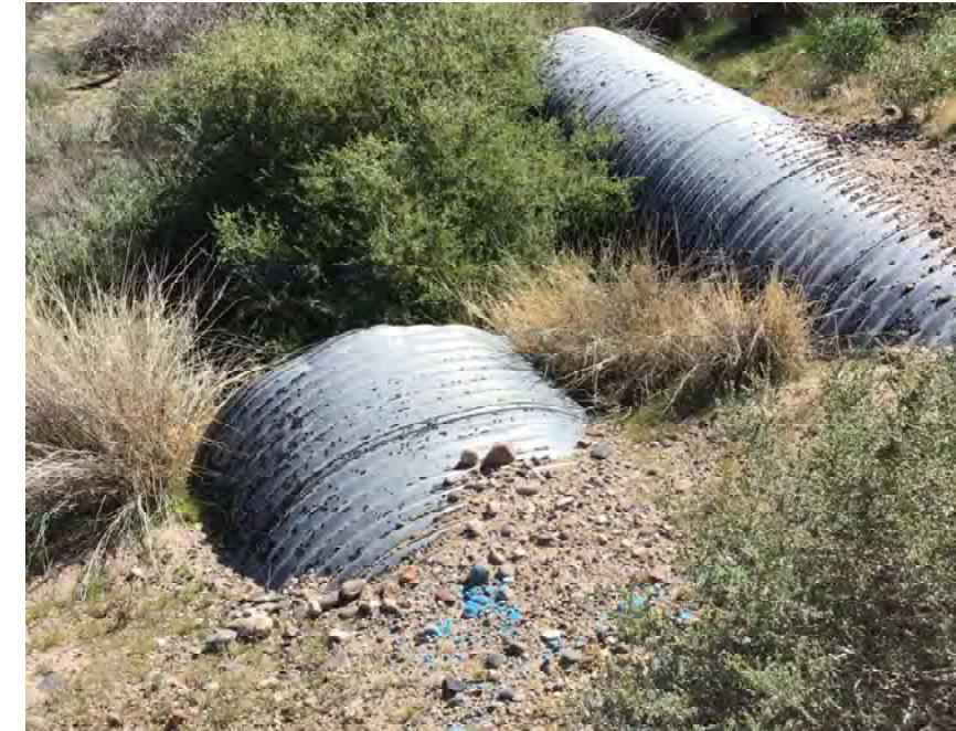
CULVERT #395 INLET (2) - 48" CMP STA 1404+47
