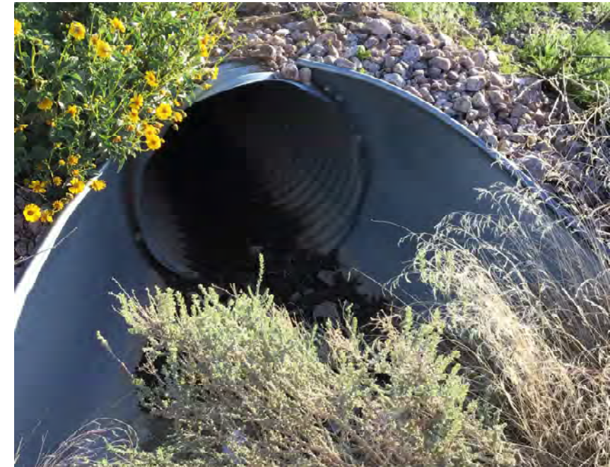
CULVERT #45 OUTLET 30" CMP STA 984+00
