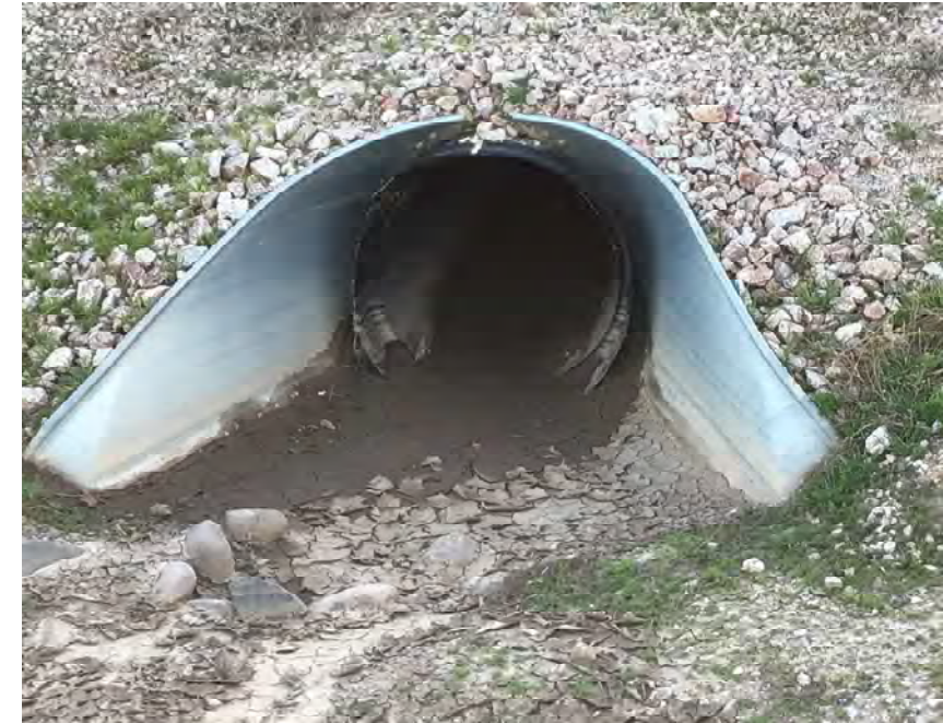
CULVERT #25 INLET HDPE 30" STA 948+00
