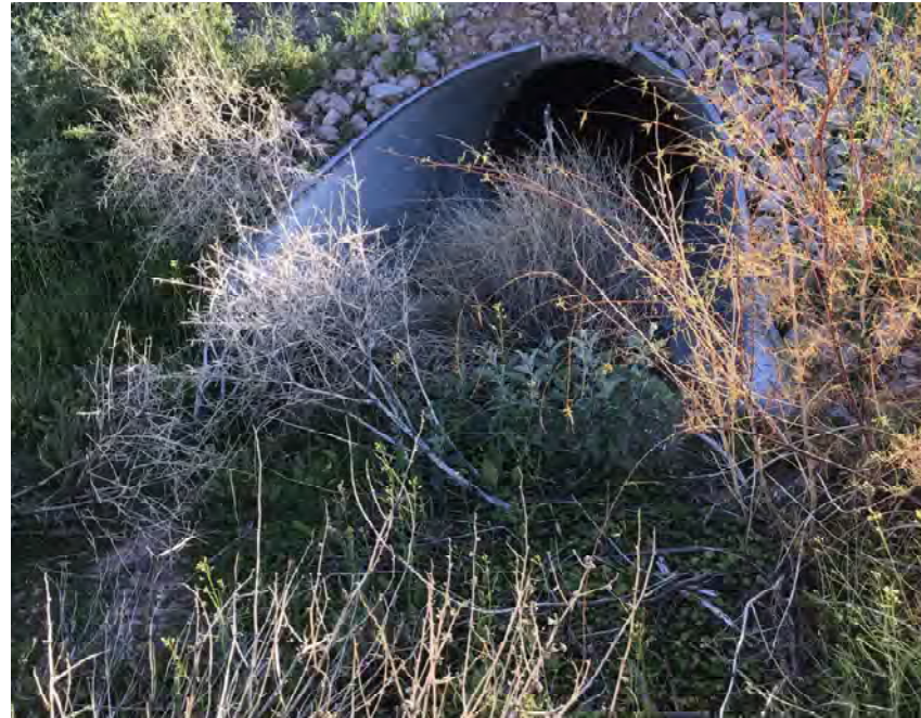
CULVERT #70 INLET 30" CMP STA 1014+00
