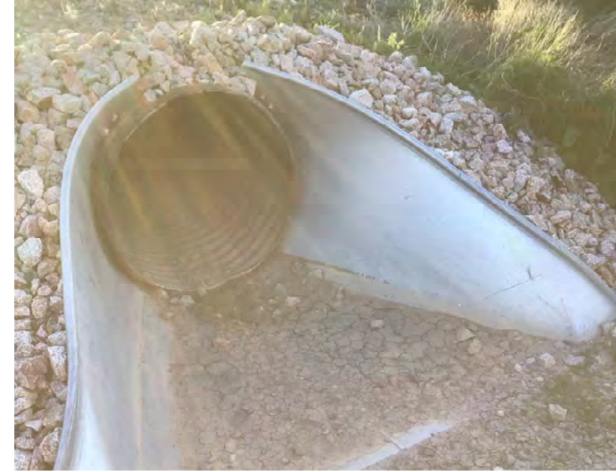
CULVERT #45 INLET 30" CMP STA 984+00
