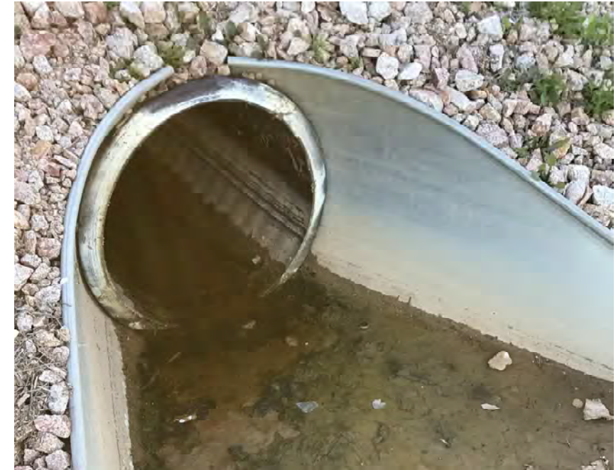
CULVERT #35 INLET 30" HDPE STA 959+00
