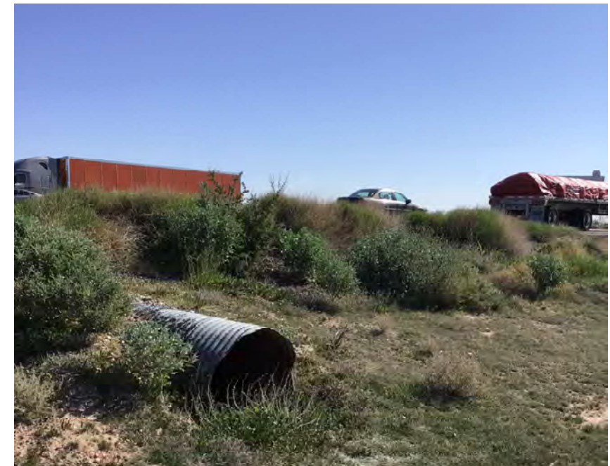
CULVERT #135 OUTLET 30" CMP STA 1097+00
