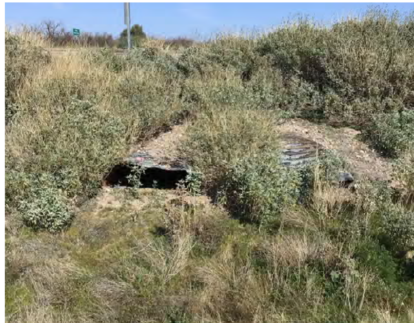
CULVERT #255 OUTLET (2) - 43" X 27" CMP ARCH STA 1243+00
