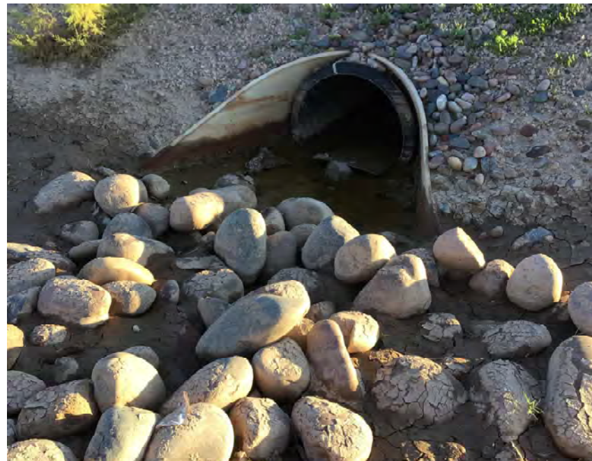
CULVERT #20 OUTLET 30" HDPE STA 945+10
