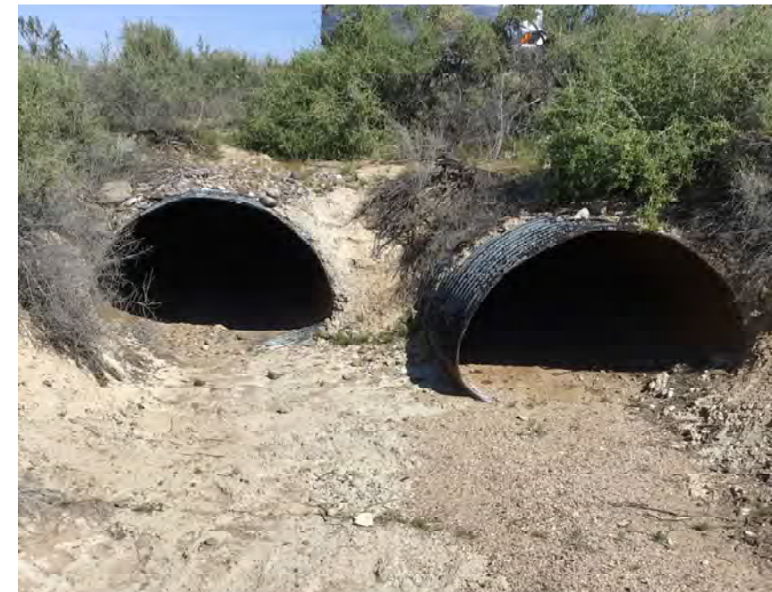
CULVERT #435 OUTLET (2) - 58" X 36" CMP ARCH STA 1461+83
