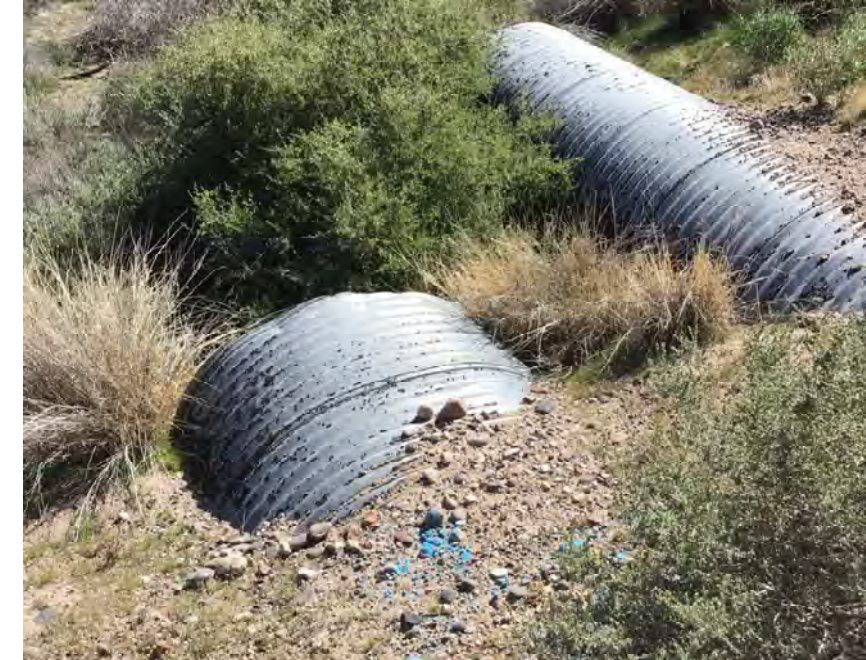
CULVERT #395 INLET (2) - 48" CMP STA 1404+47
