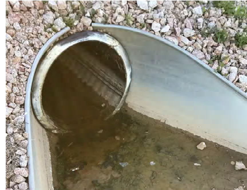
CULVERT #35 INLET 30" HDPE STA 959+00
