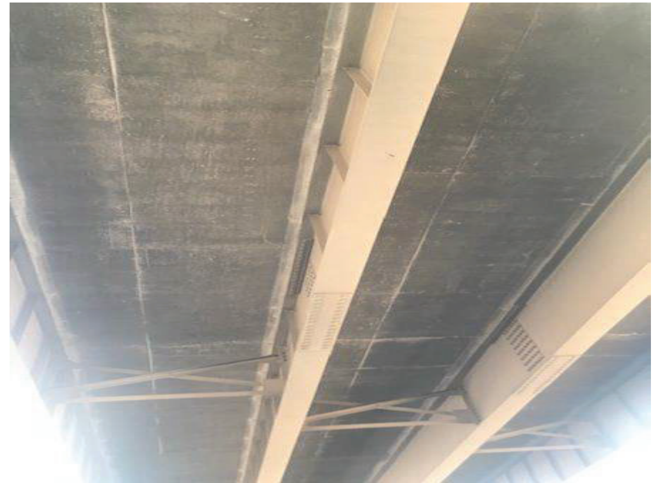
File Name : 01213-2021-05-18-Photo-4.jpg Description : Soffit
