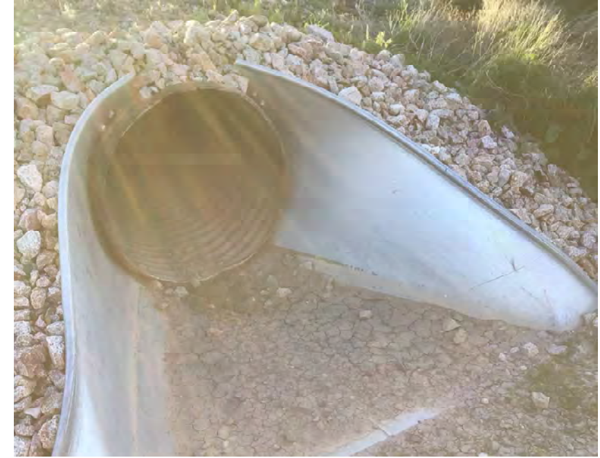
CULVERT #45 INLET 30" CMP STA 984+00
