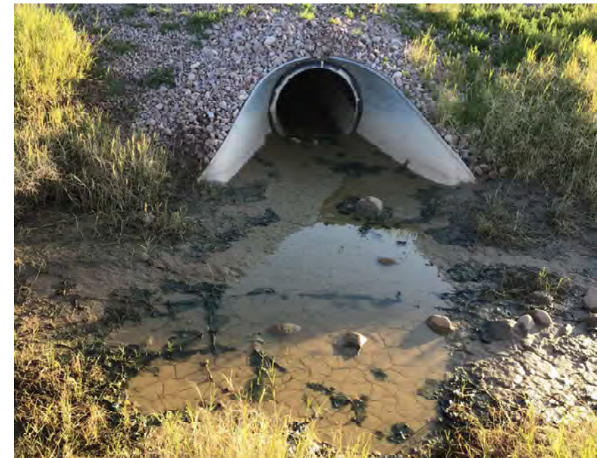
CULVERT #35 OUTLET 30" HDPE STA 959+00
