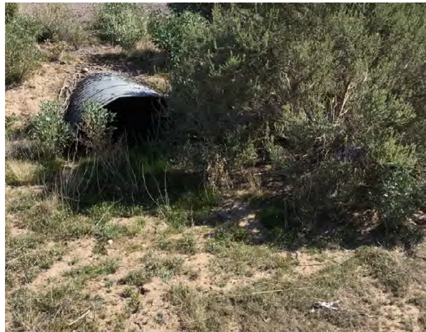
CULVERT #410 OUTLET (2) - 43" X 27" CMP ARCH STA 1423+00
