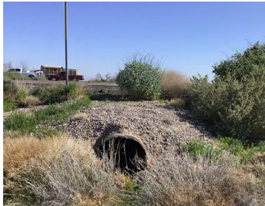
CULVERT #110 OUTLET 30" CMP STA 1064+00
