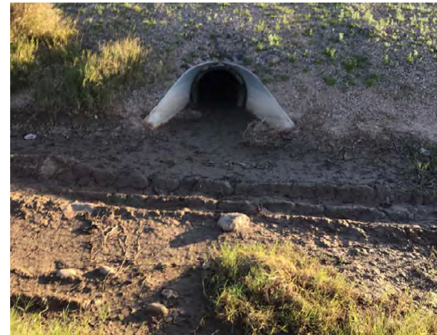
CULVERT #25 OUTLET HDPE 30" STA 948+00
