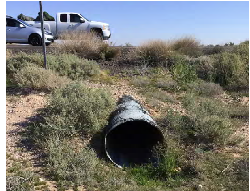
CULVERT #125 OUTLET 30" CMP STA 1083+00
