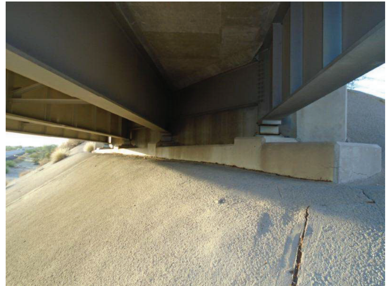
File Name : 01150-2020-05-31-Photo-10.JPG Description : N Abutment, LNW
