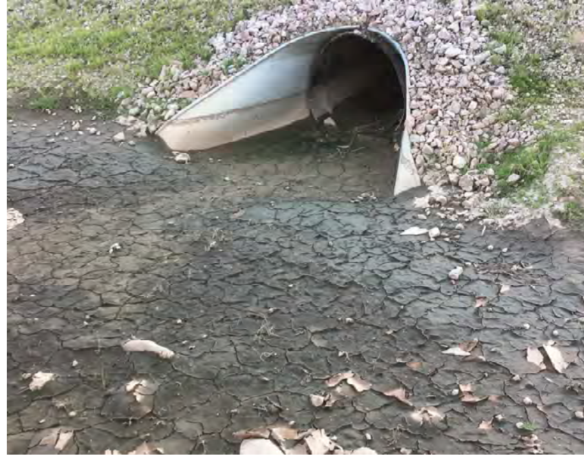
CULVERT #40 INLET 30" HDPE STA 964+00
