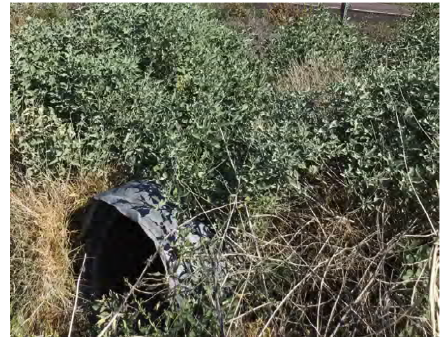
CULVERT #105 OUTLET 30" CMP STA 1061+00
