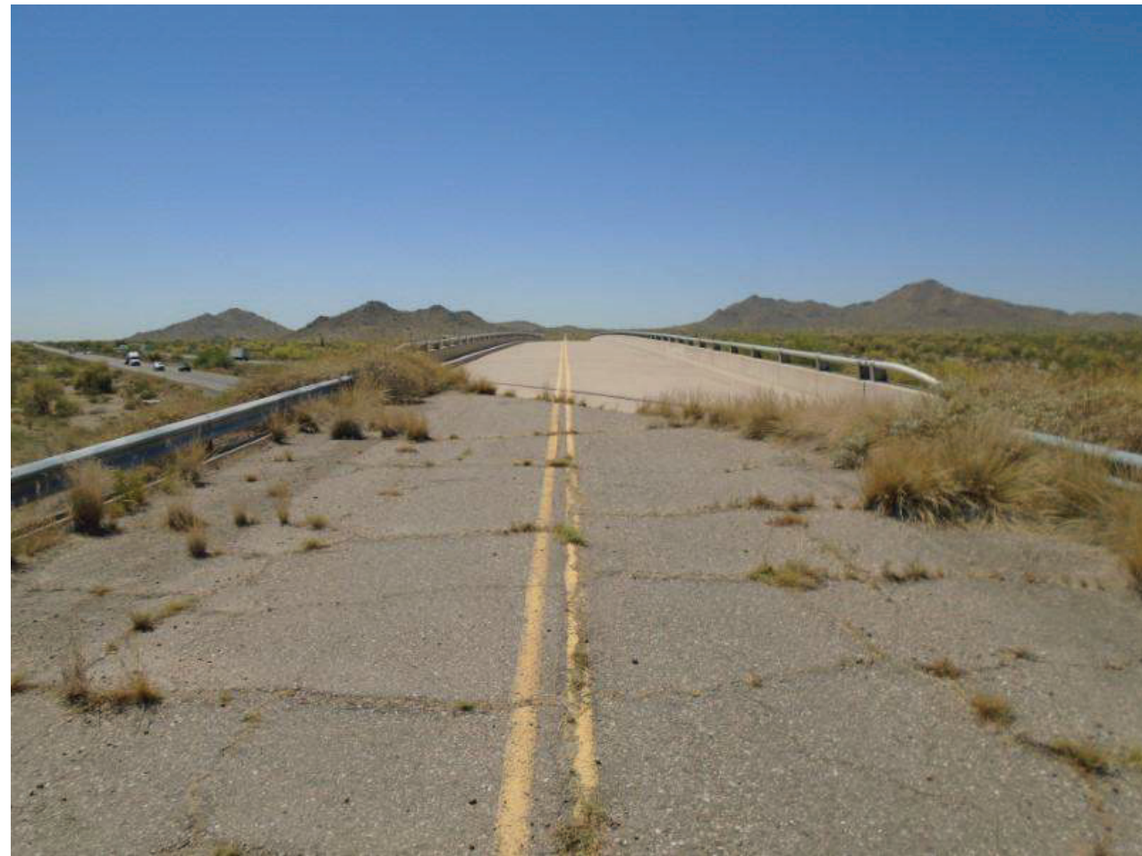
File Name : 01150-2020-05-31-Photo-1.JPG Description : Roadway ID LS
