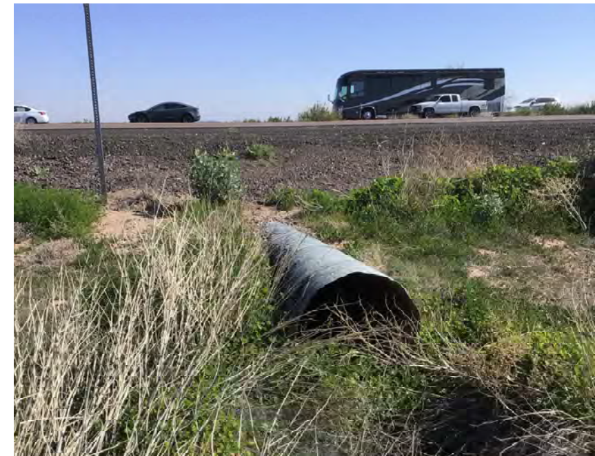
CULVERT #115 OUTLET 30" CMP STA 1070+00
