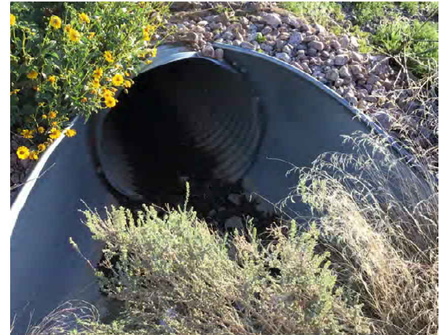
CULVERT #45 OUTLET 30" CMP STA 984+00
