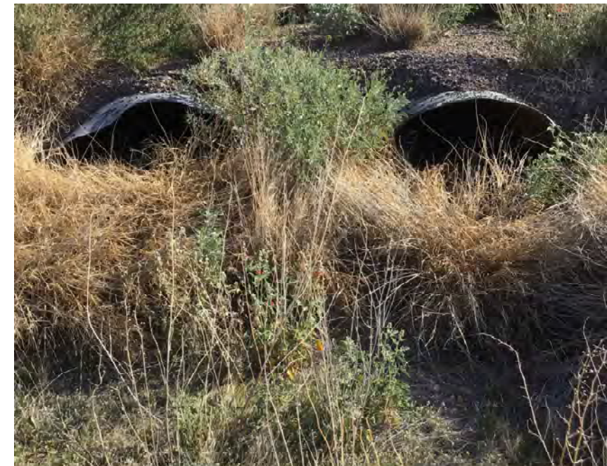
CULVERT #325 OUTLET (2) - 43" X 27" CMP ARCH STA 1311+00
