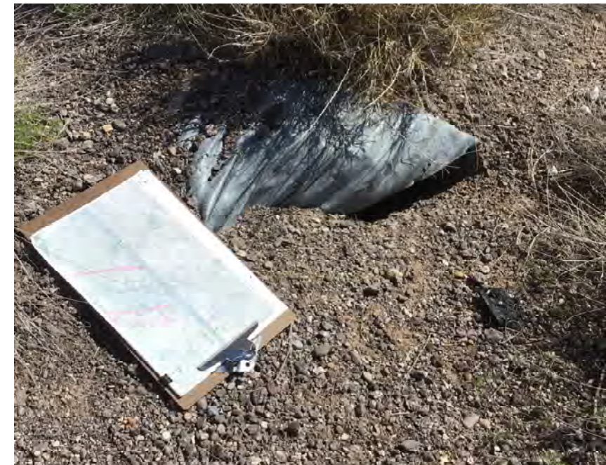
CULVERT #200 OUTLET 30" CMP STA 1180+00
