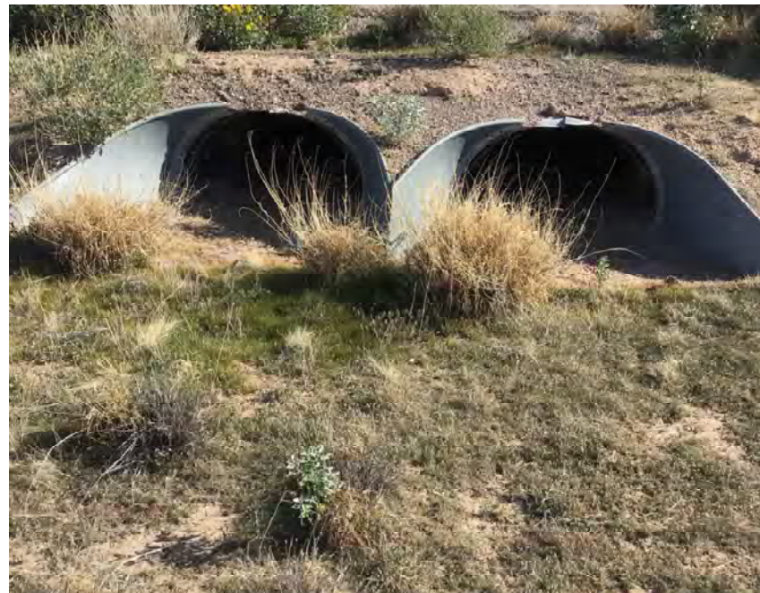
CULVERT #350 OUTLET (2) - 43" X 27" CMP ARCH STA 1341+00
