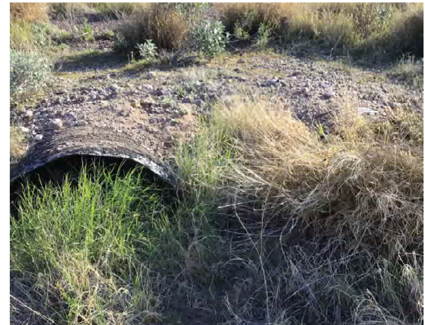
CULVERT #280 OUTLET (2) - 43" X 27" CMP ARCH STA 1261+00
