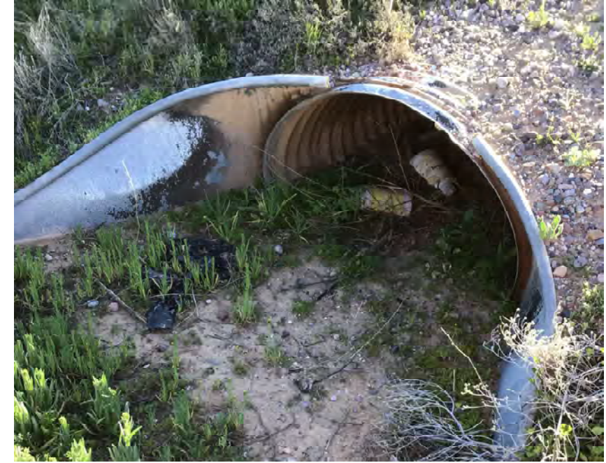
CULVERT #85 INLET 30" CMP STA 1033+00
