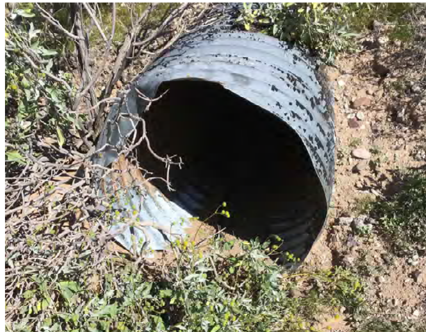
CULVERT #190 OUTLET 30" CMP STA 1156+56
