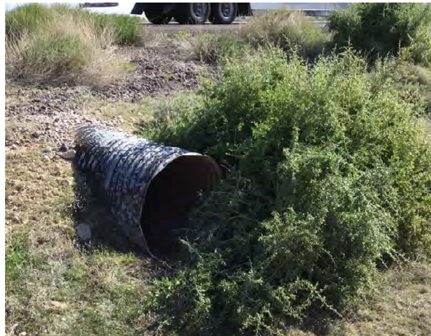
CULVERT #130 OUTLET 30" CMP STA 1093+00
