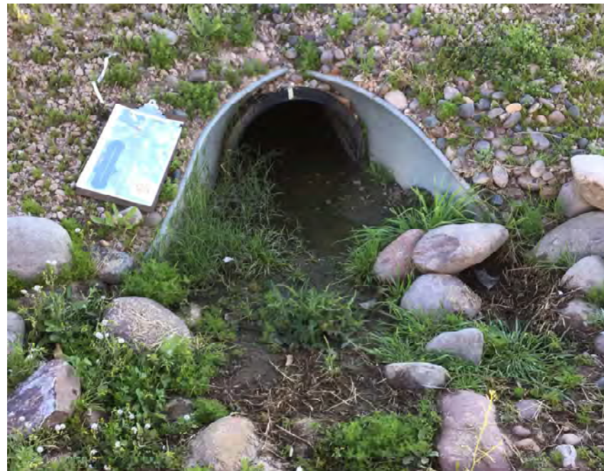
CULVERT #10 OUTLET 24" HDPE STA 929+00
