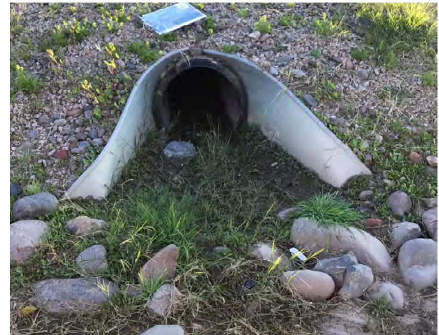
CULVERT #15 OUTLET 24" HDPE STA 937+00
