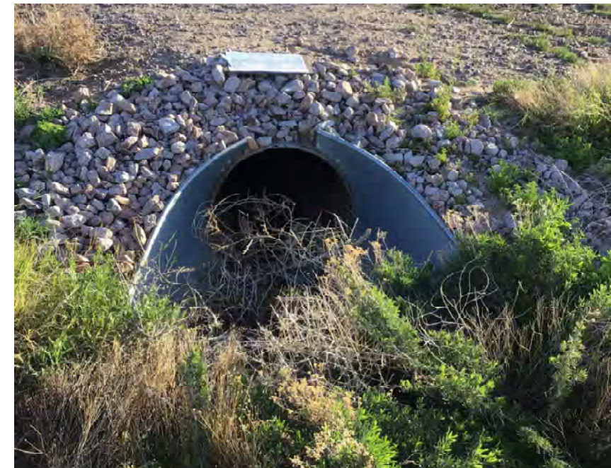
CULVERT #55 OUTLET 30" CMP STA 996+00
