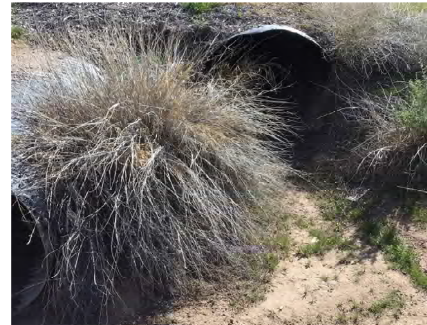
CULVERT #395 OUTLET (2) - 48" CMP STA 1404+47
