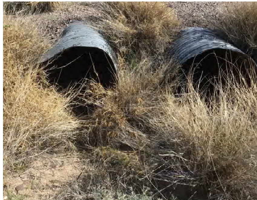
CULVERT #400 OUTLET (2) - 36" CMP STA 1411+00
