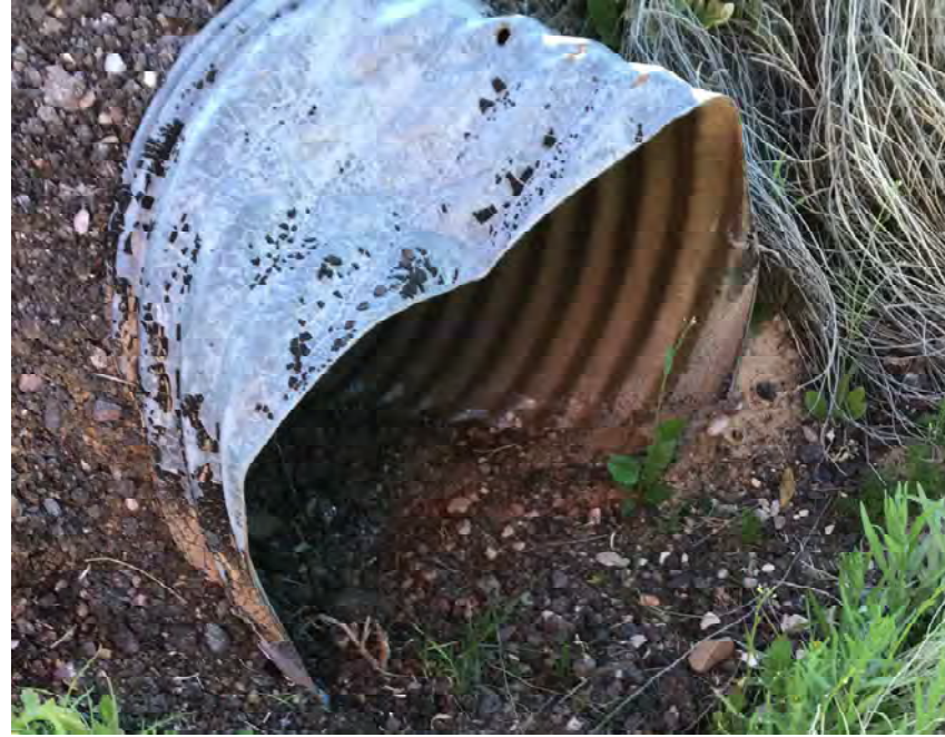
CULVERT #90 INLET 30" CMP STA 1041+00
