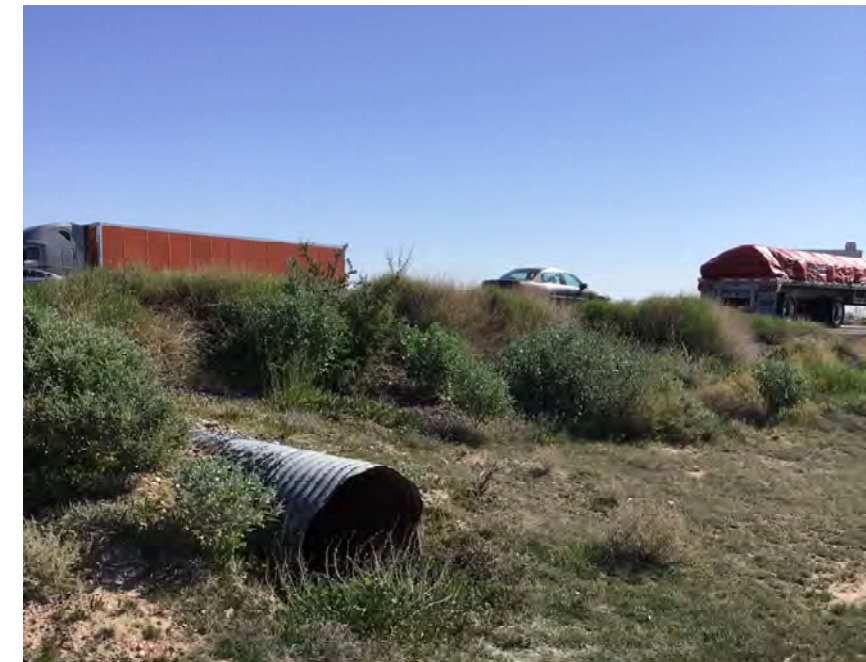
CULVERT #135 OUTLET 30" CMP STA 1097+00
