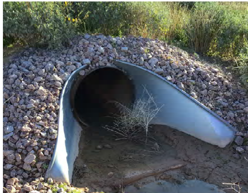
CULVERT #70 OUTLET 30" CMP STA 1014+00
